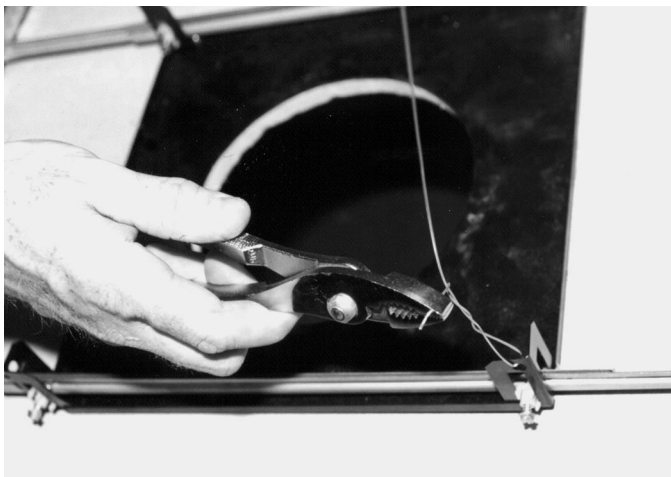
Figura 8.4: Sujeción del conjunto de soporte
